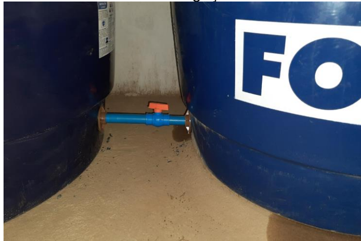
FIGURA 5 - Modelo de ligação entre os reservatórios.
