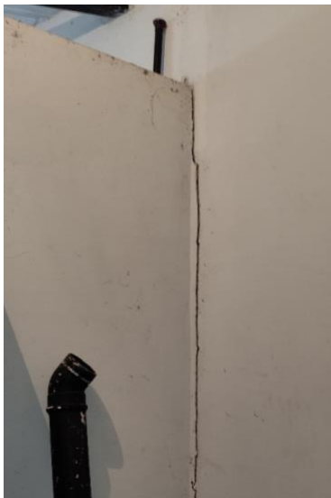
Figura 11 – Porta do depósito, mostrando a brecha de um lado da alvenaria e o outro lado ainda fixo ao chão.
