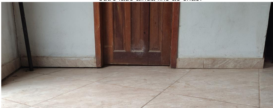
Figura 11 – Porta do depósito, mostrando a brecha de um lado da alvenaria e o outro lado ainda fixo ao chão.
