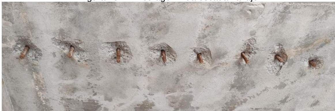
Figura 18 - “Ancoragem” da escada na laje.
