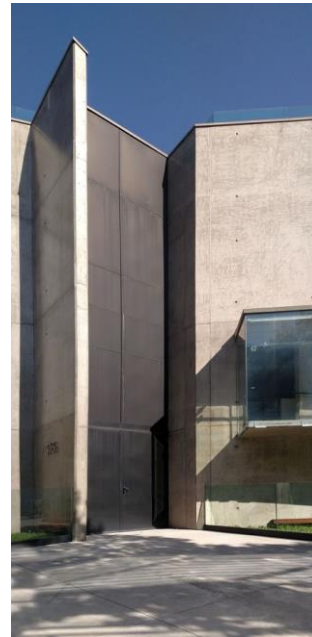
Figura 03 – acesso de pedestre
