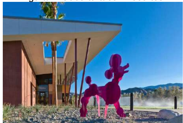
Figura 7: Cobertura com recortes
