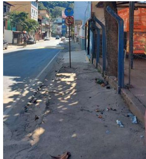
Figura 4: Placas em mal estado e pavimentação descontinua
