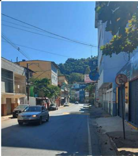
Figura 3: Rebaixo inadequado das calçadas
