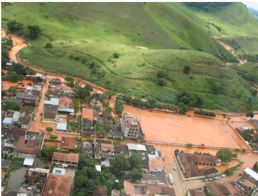
FIGURA 4: Vista aérea da cidade de Muriaé após rompimento da barragem
