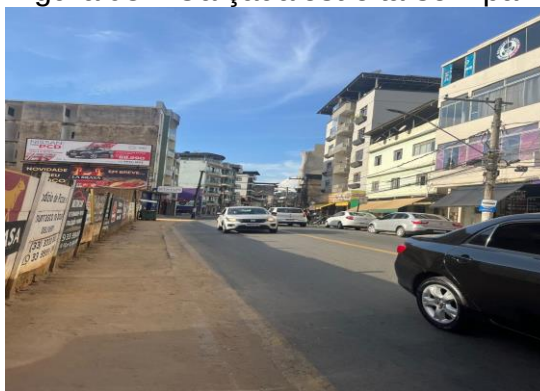
Figura 08 – Calçada estreita sem pavimentação
