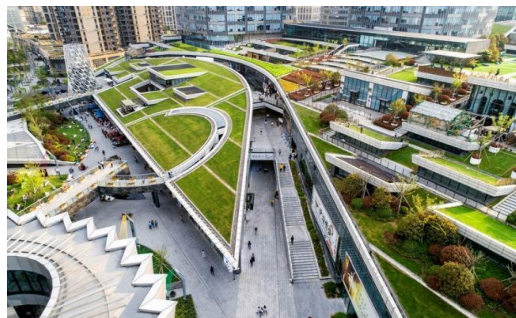
FIGURA 12 – Cobertura do Greenland Center
