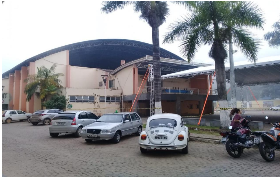
FIGURA 11 - Vista do estacionamento da Praça Antides Faria
