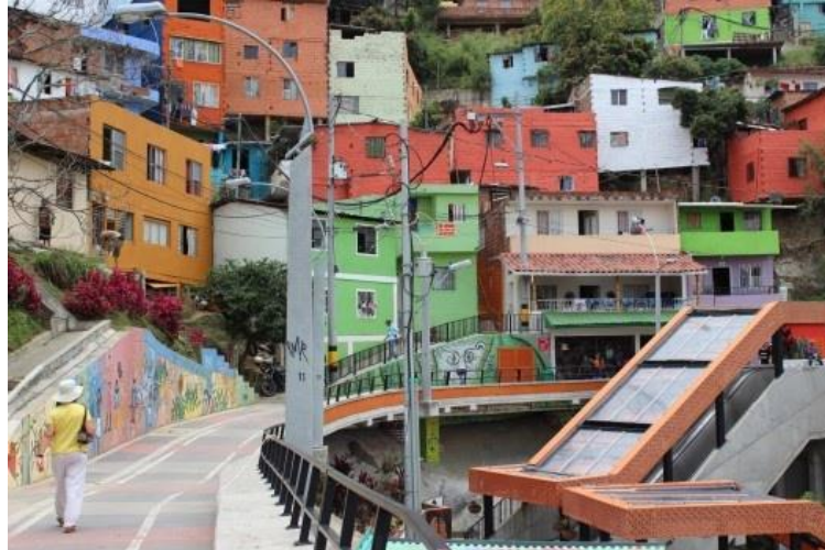
Figura 11 - Intervenções de fachadas e rua -Comuna 13
