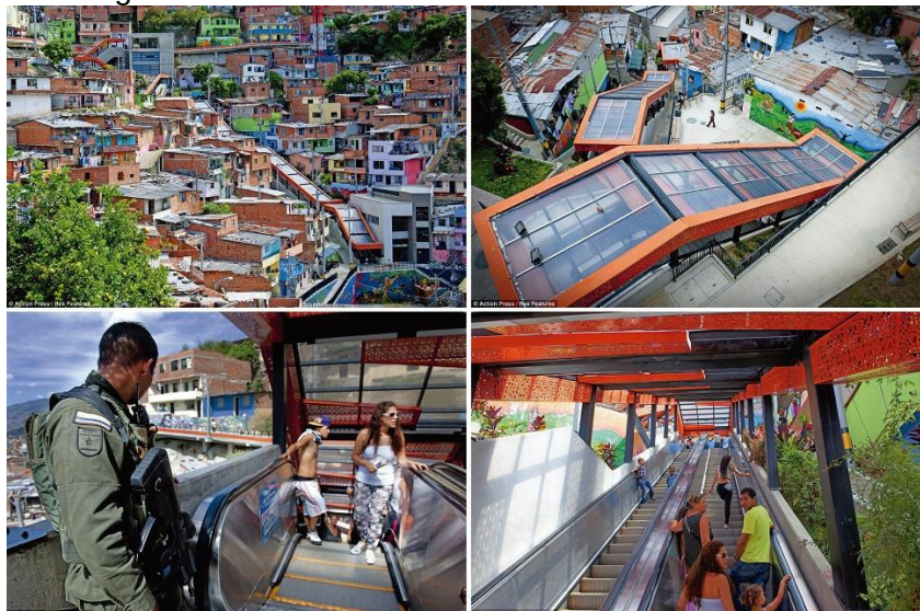
Figura 10 – Sistema de escada rolante – Comuna 13
