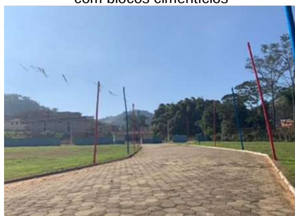
Figura 17 – Vista do caminho pavimentado com blocos cimentícios
