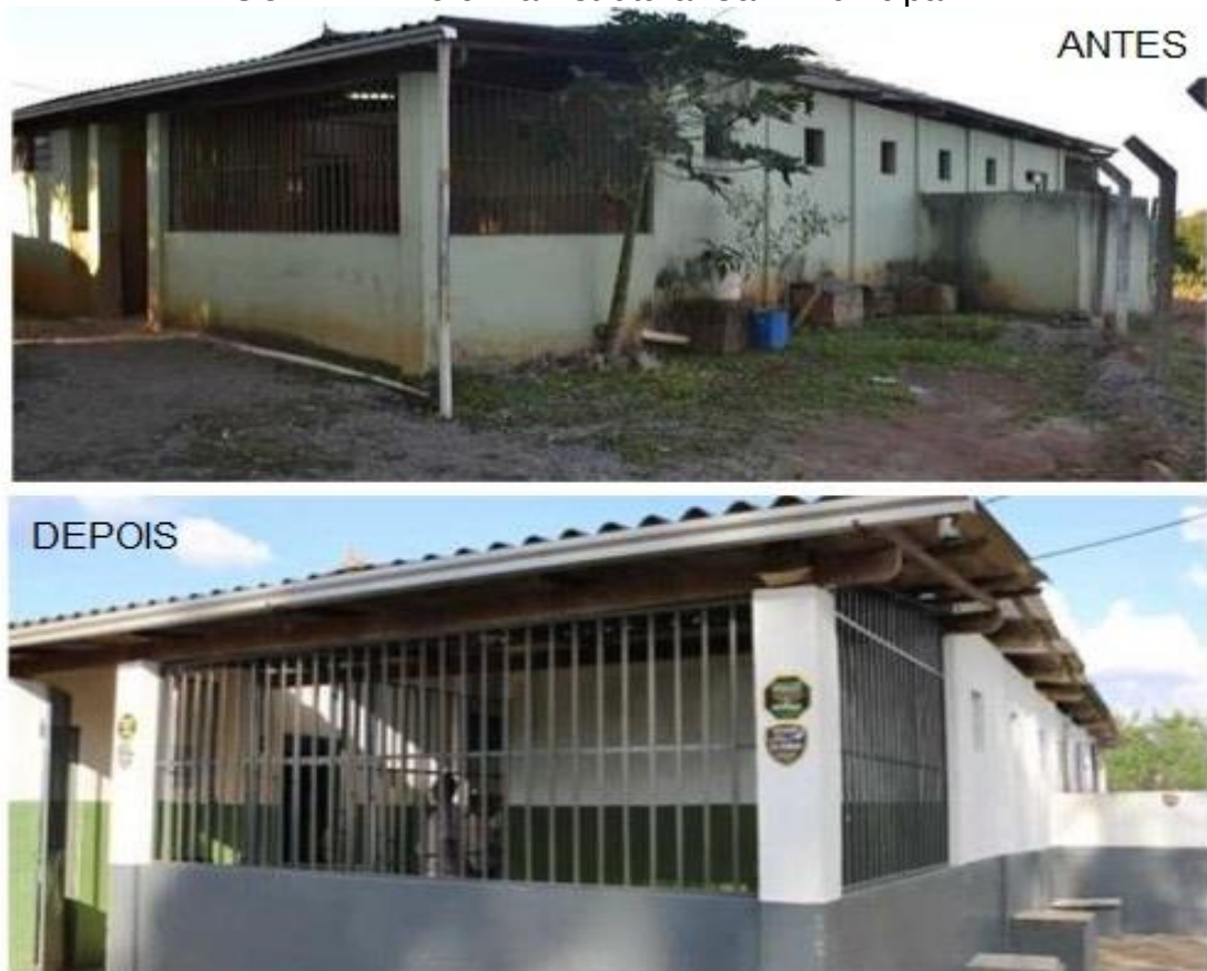
FIGURA 12: Reforma Estrutural Canil Municipal
