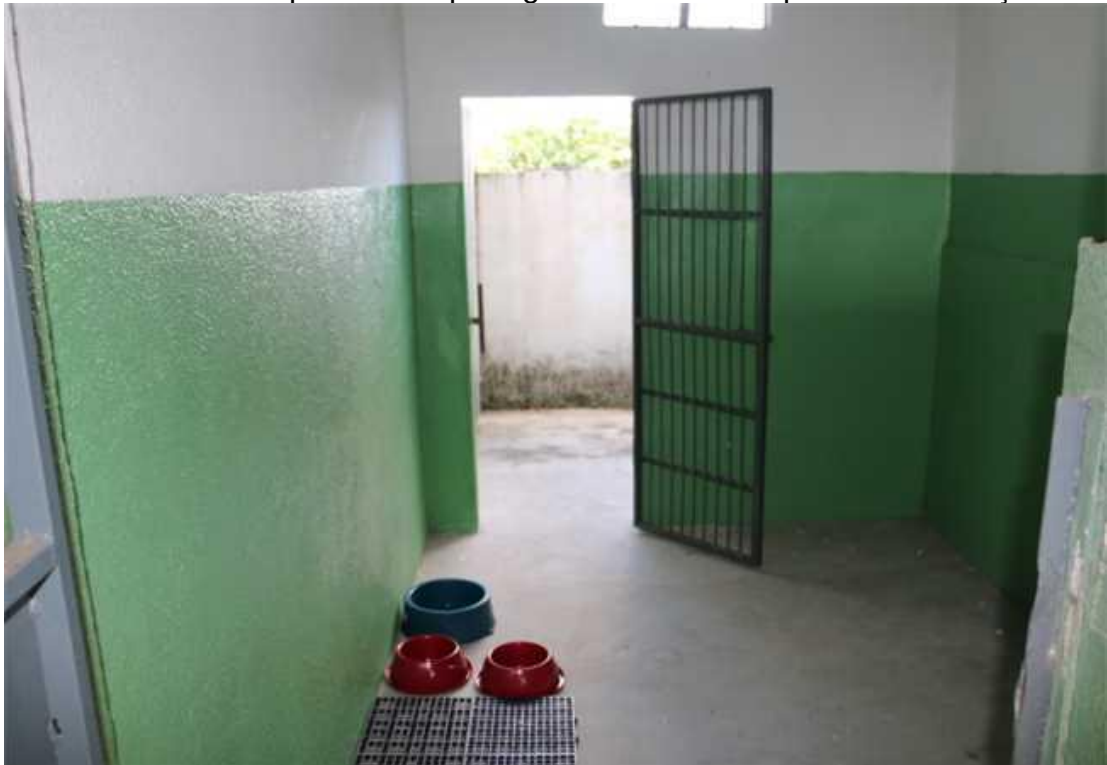
FIGURA 14: Compartimento para gatos Canil Municipal de Manhuaçu
