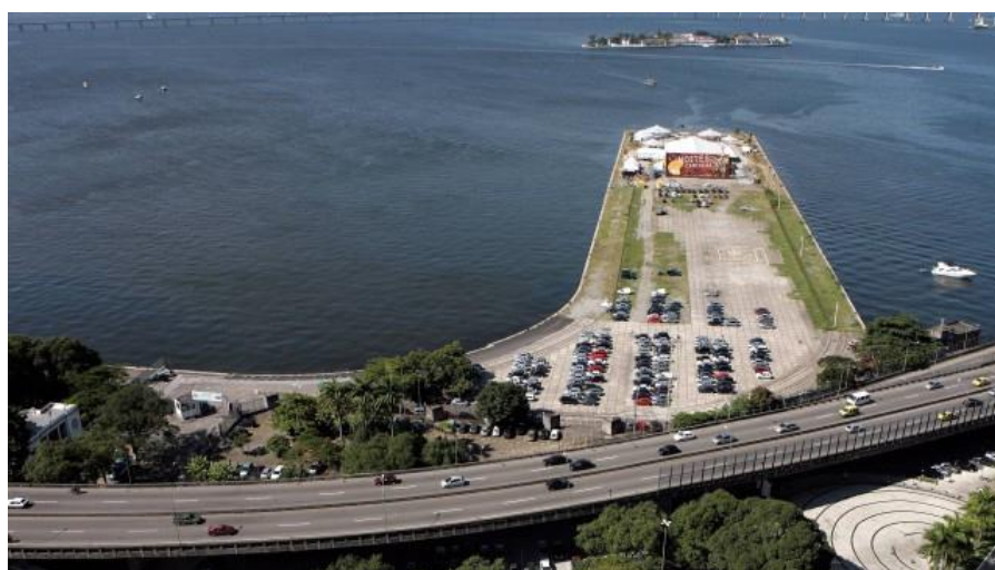
Figura 5- Antigo Elevado Perimetral e Praça Mauá
