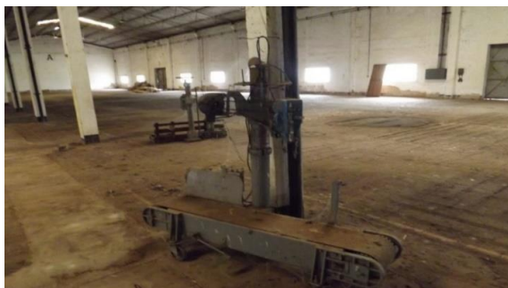
Figura 20 - Galpão IBC internamente
