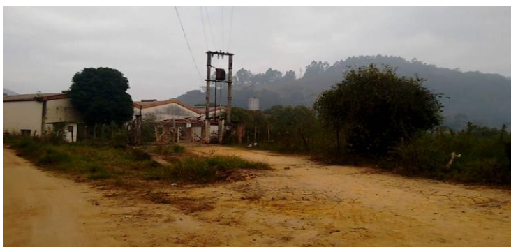
Figura 19 - Entrada Antigo IBC
