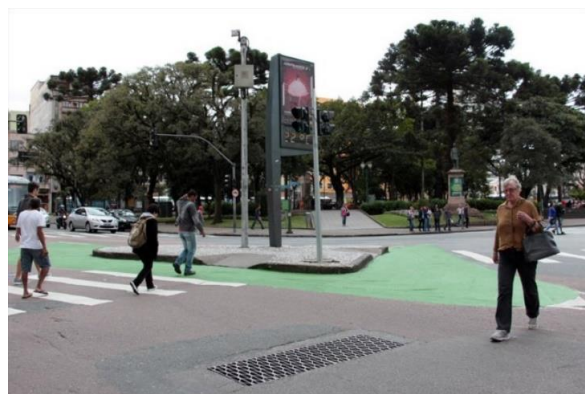
Figura 18- Calçada verde ampliando área do pedestre
