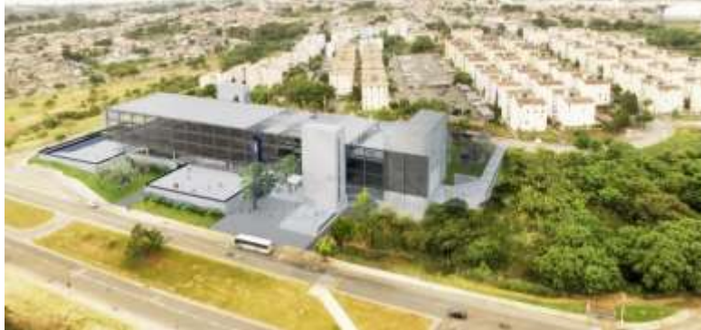
FIGURA 05 – Perspectiva geral da edificação
