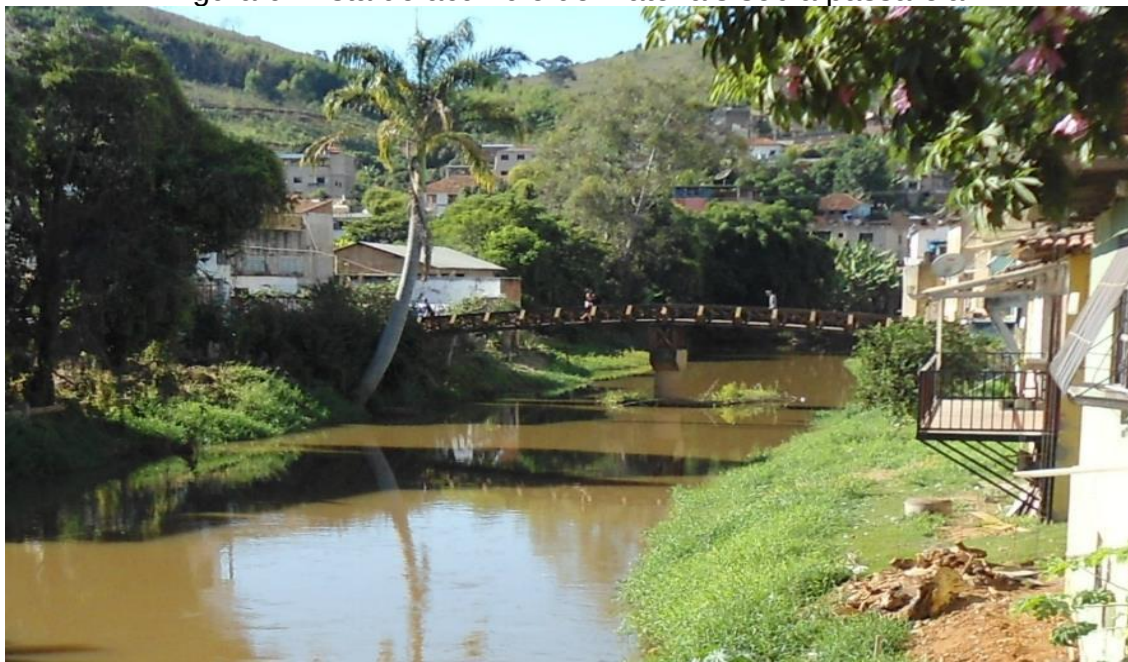
Figura 6: Vista do acúmulo de materiais sob a passarela.
