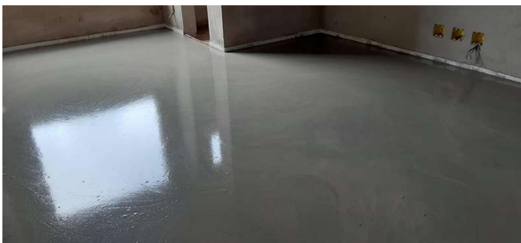
Figura 8: Contrapiso finalizado em processo de cura.
