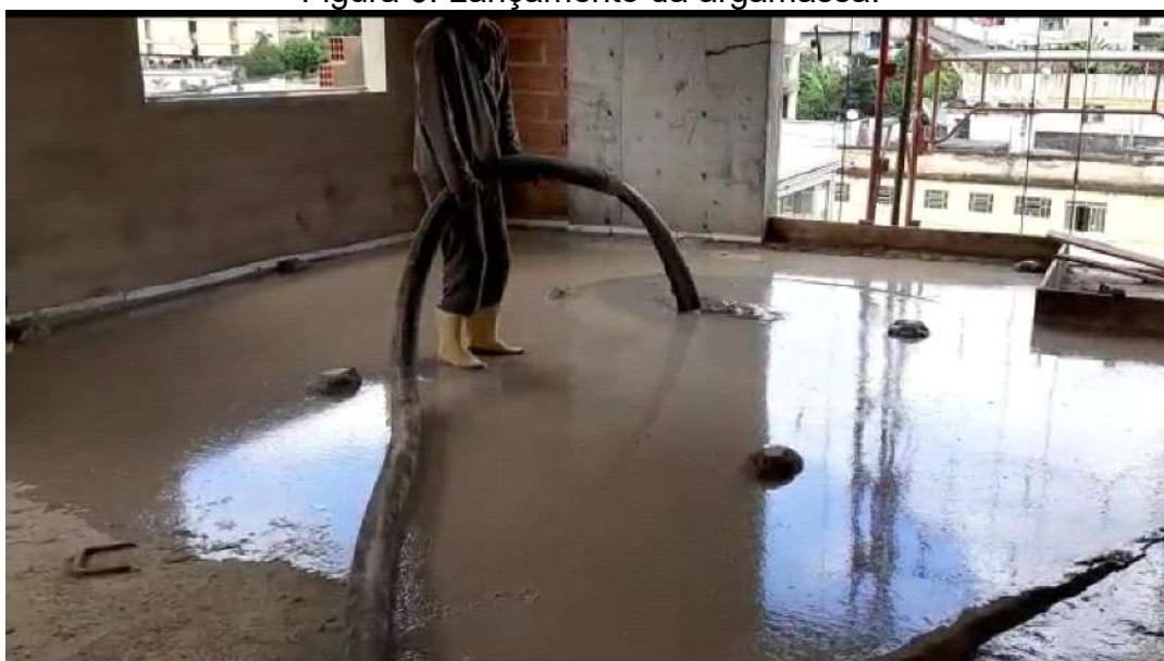
Figura 6: Lançamento da argamassa.
