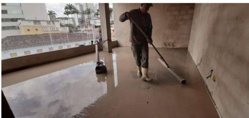
Figura 7: Lançamento da argamassa.
