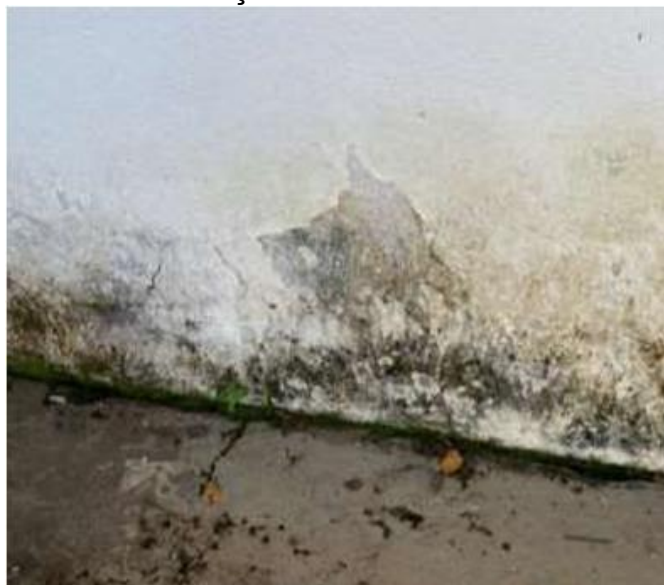
FIGURA 6 – Proliferação de mofos e bolores na alvenaria
