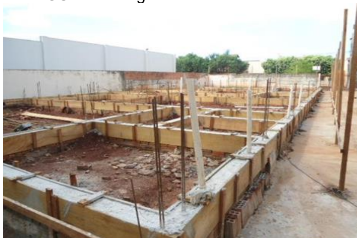
FIGURA 1 – Vigas baldrames concretadas
