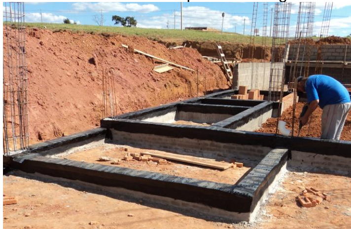
FIGURA 3 – Manta asfáltica aplicada em vigas baldrame
