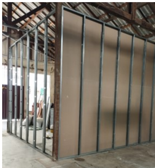
FIGURA 4 - Estrutura de perfis metálicos de drywall
