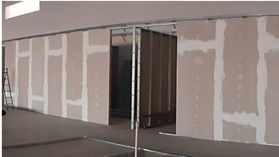
FIGURA 3 - Paredes de Drywall sendo instaladas
