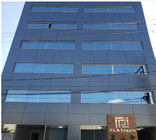
FIGURA 8 – Fachada do edifício em estudo
