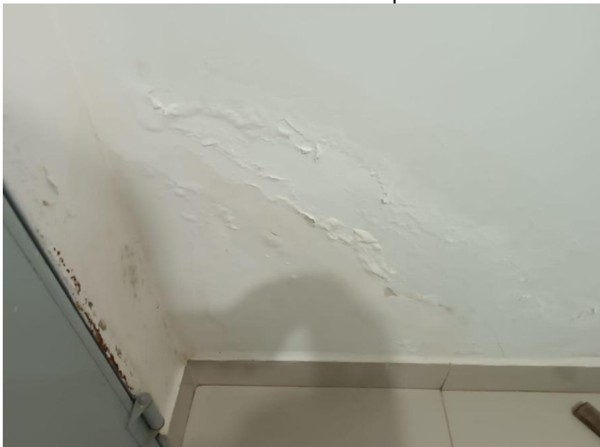
FIGURA 16 – Bolhas na pintura
