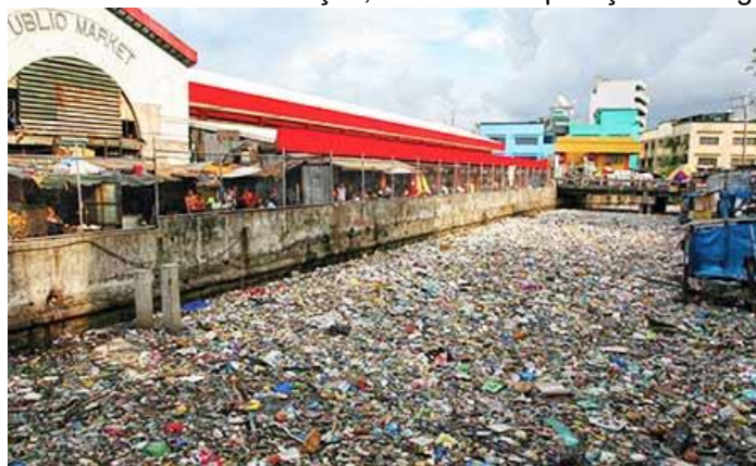
Figura 11 – Canal Paco antes da revitalização, mostrando a poluição e a degradação ambiental.
