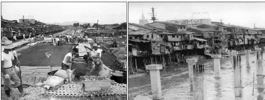
Figuras 3 e 4 – Antiga ocupação da várzea do rio Cheonggyecheon e tamponamento do leito
