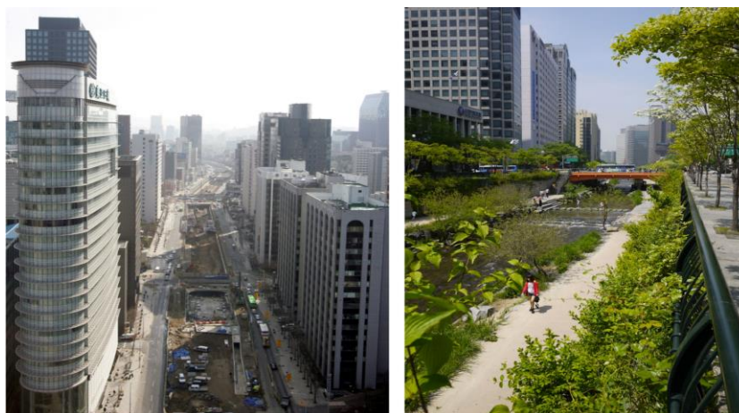
Figura 7 e 8– Etapas do processo de revitalização: demolição da via e reabertura do leito do rio Cheonggyecheon.
