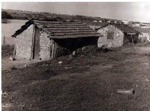
Figura 15 – Casebres na antiga orla do rio onde hoje é a avenida Beira Rio
