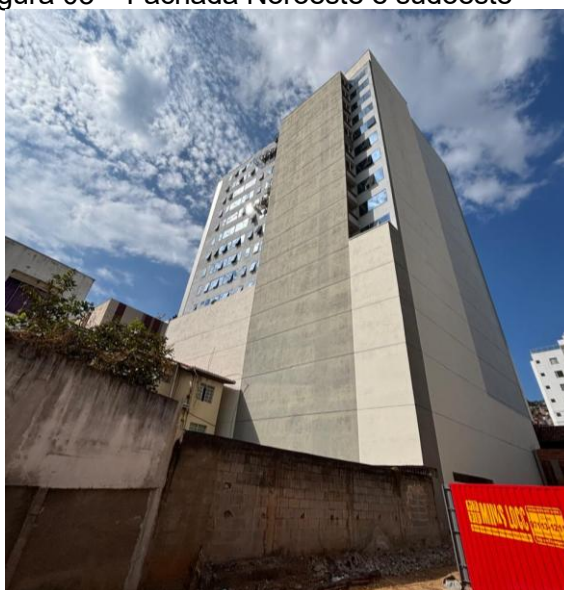
Figura 03 – Fachada Noroeste e sudoeste
