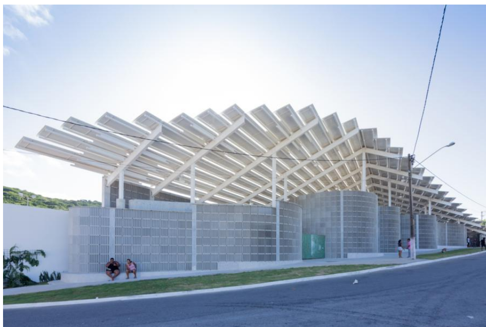
Figura 03 – Fachada e cobertura da Arena do Morro, Natal/RN.
