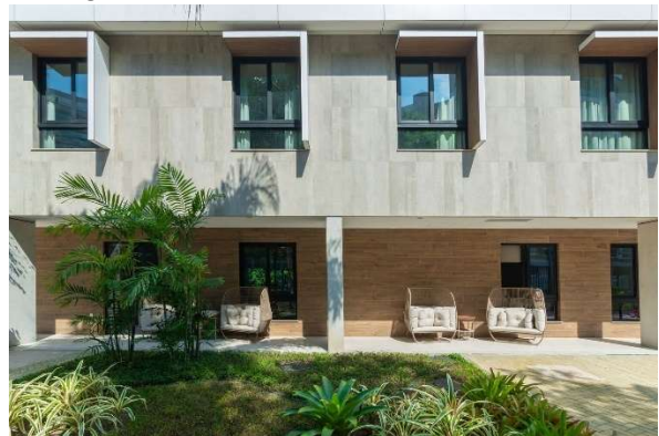
Figura 15 – Detalhe estético fachada
