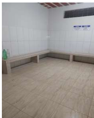
Figura 37 – Vista interna dos vestiários do E.C.V e vista geral do local em horário noturno
