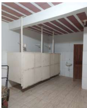
Figura 36 – Vista interna dos vestiários do E.C.V e vista geral do local em horário noturno
