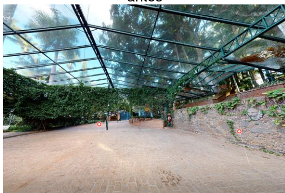
Figura 35: Vista geral da tenda de cristal – antes
