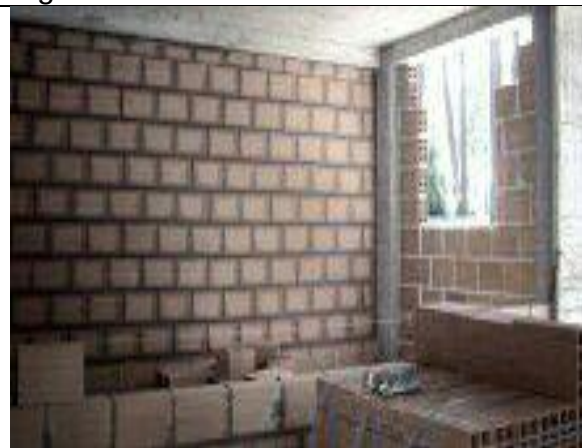
Figura 2– Parede de bloco cerâmico.
