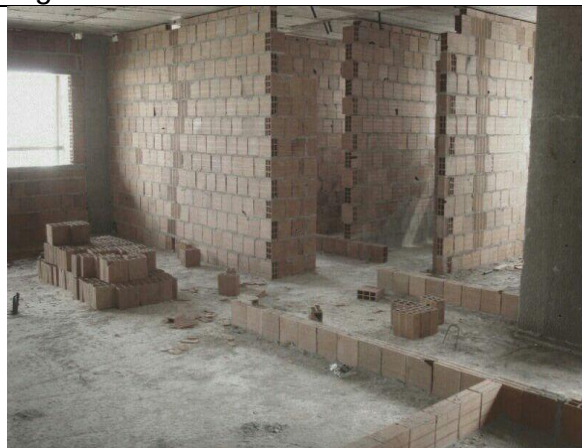
Figura 1 – Parede de bloco cerâmico.
