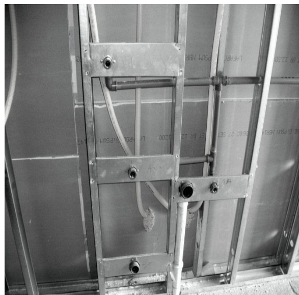
Figura 10 - Instalações hidráulicas, gás.
