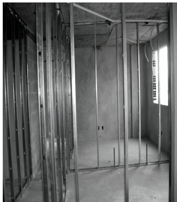
Figura 6 - Fixação dos montantes.
