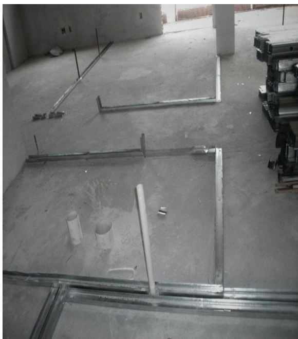
Figura 5 - Fixação das guias.
