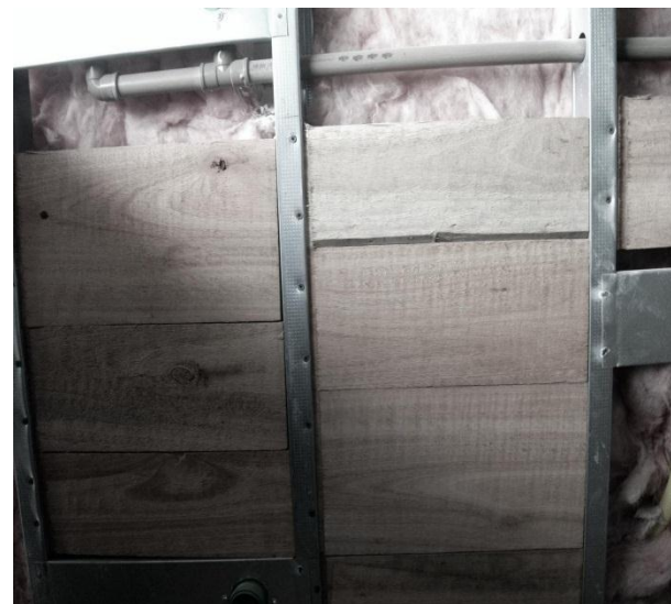
Figura 8 - Colocação dos reforços de madeira.
