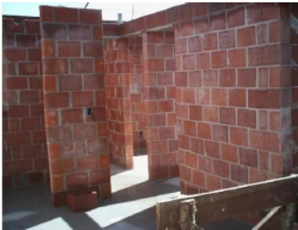
FIGURA 4 - Paredes de blocos cerâmicos
