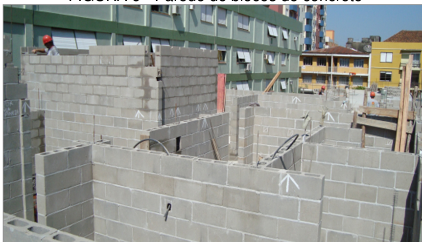
FIGURA 6 - Parede de blocos de concreto
