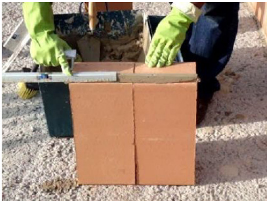
FIGURA 17 – Trabalhador utilizando Meia Cana Metálica
