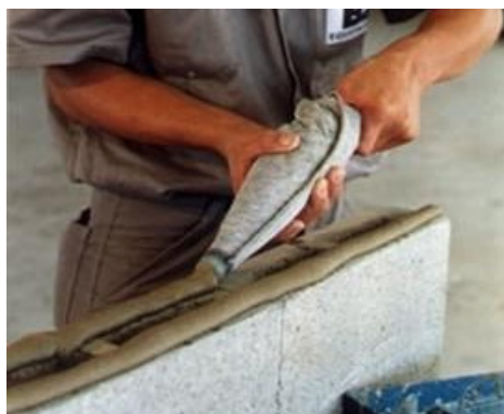
FIGURA 15 – Trabalhador utilizando Bisnaga
