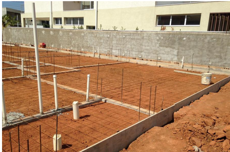
FIGURA 18 –Preparação para Contra Piso em Alvenaria Estrutural
