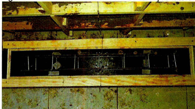
Figura 7 – Detalhe da forma com os reforços laterais
