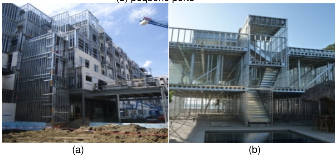
FIGURA 7 – Exemplos da utilização de PFF : edificações de (a) grande porte (b) pequeno porte
