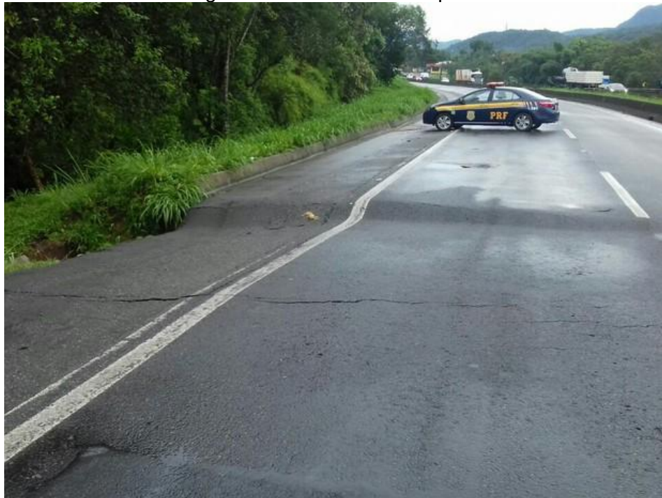
Figura 3 - Afundamento de pista
