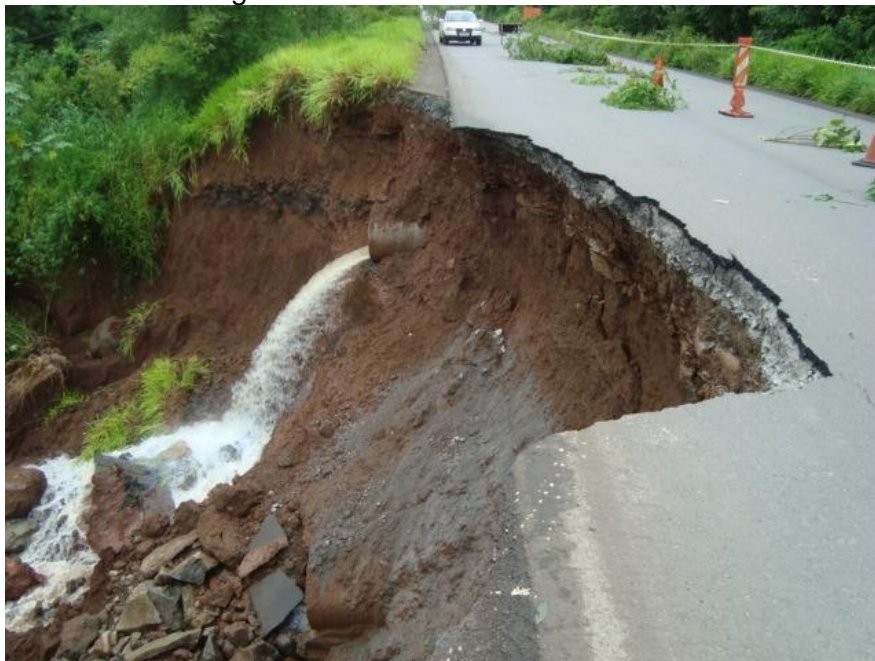
Figura 5 - Erosão em estradas
