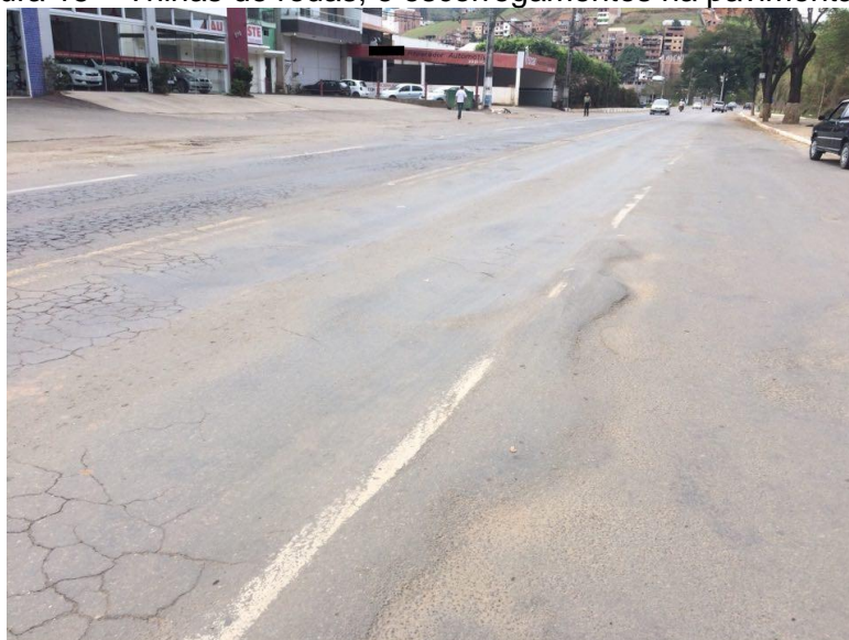
Figura 15 – Trilhas de rodas, e escorregamentos na pavimentação
