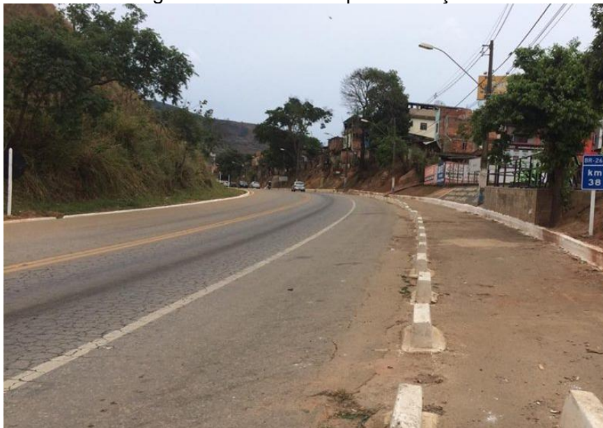
Figura 12 – Trincas na pavimentação
