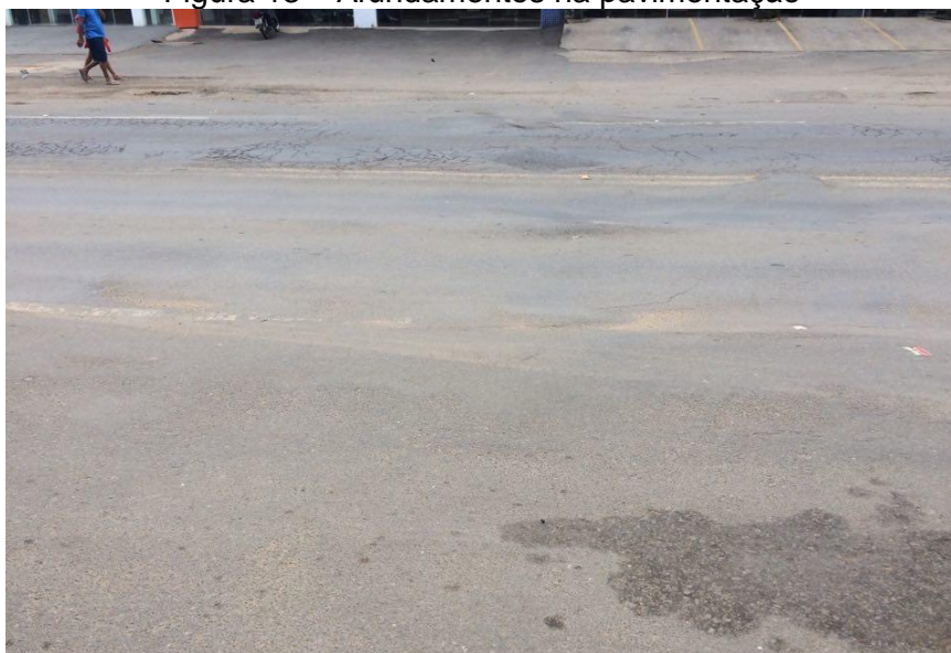
Figura 13 – Afundamentos na pavimentação
