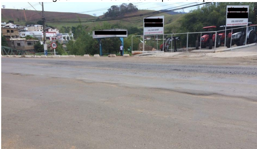
Figura 14 – Afundamentos na pavimentação
