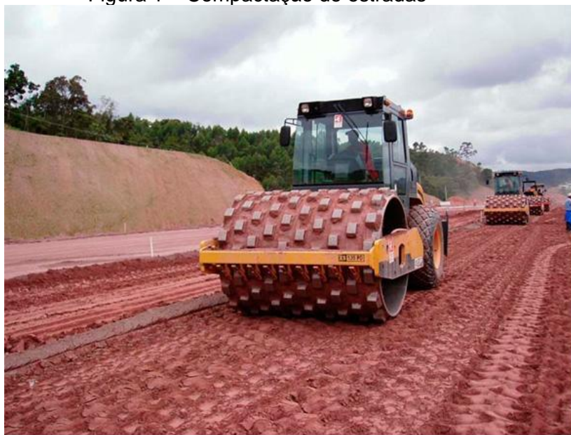
Figura 1 – Compactação de estradas
