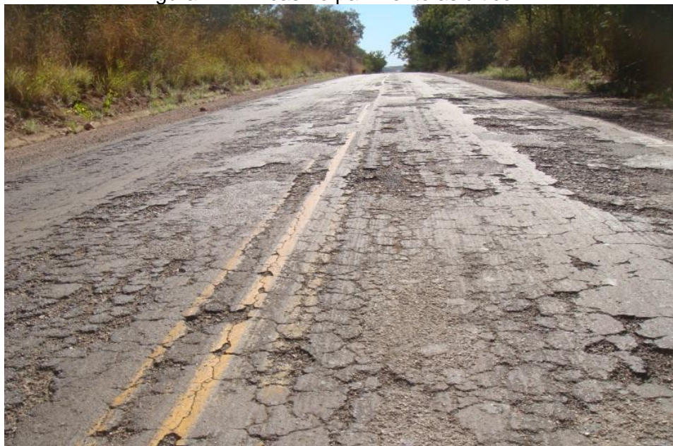
Figura 4 - Trincas no pavimento asfáltico
