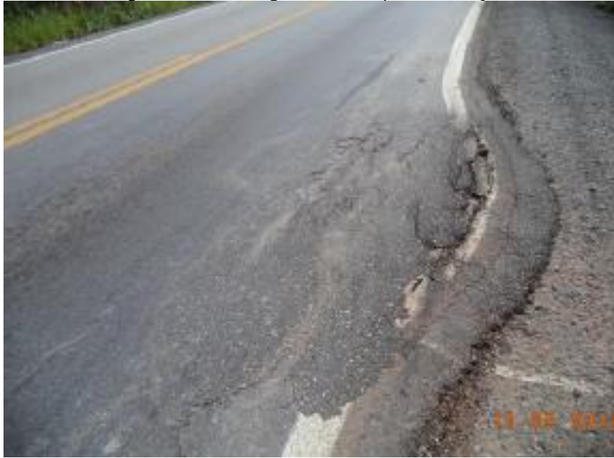
Figura 6- Escorregamento da pavimentação
