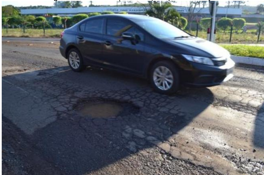
Figura 7 - Panelas (Buracos) na pavimentação
