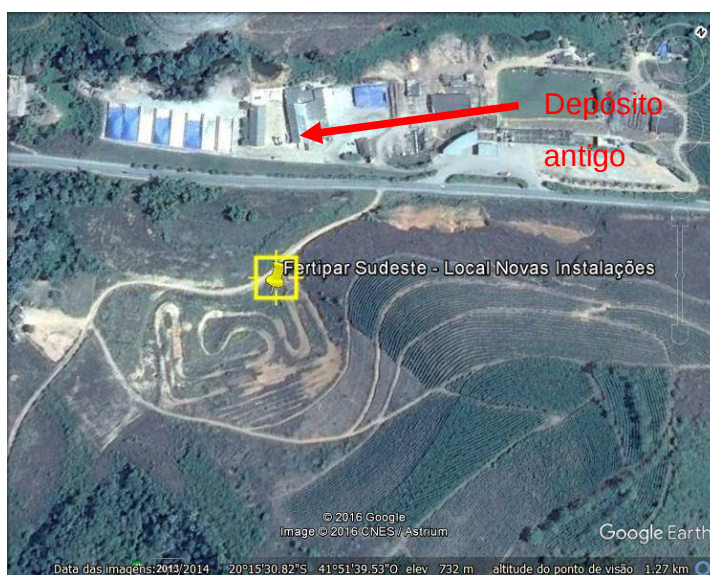
Figura 4 – Imagem de satélite antes do início das obras de terraplanagem
