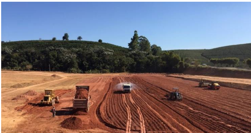
Figura 3 – Demais equipamentos, como Motoniveladora, Caminhão Basculante, Caminhão Pipa, Trator com Grade, e Rolo Compactador
