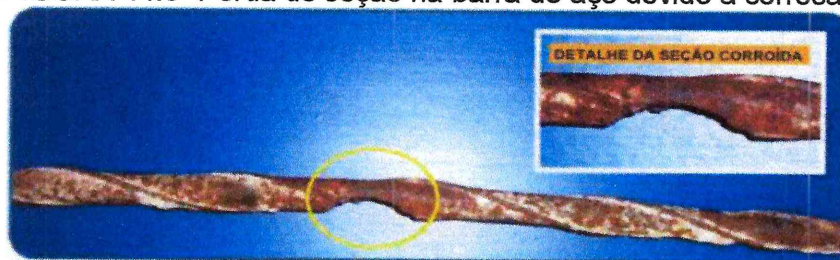
FIGURA 11.0- Perda de seção na barra de aço devido a corrosão
