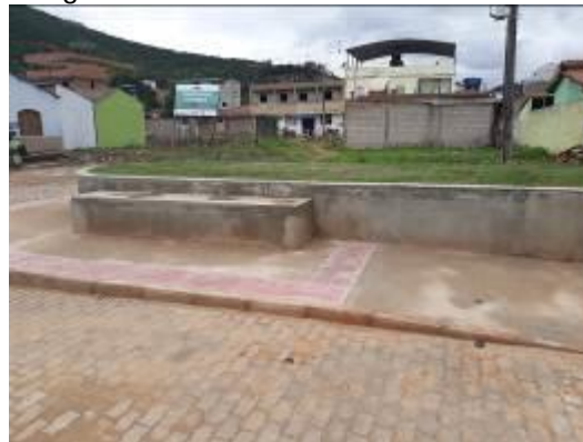
Figura 18 – Vista do Banco de Concreto
