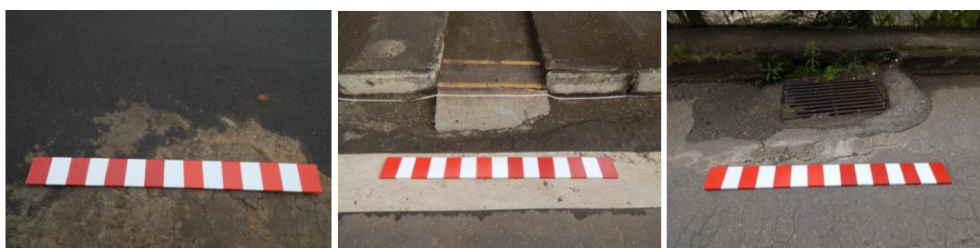
Figura 11 - Defeitos não classificados pelo DNIT: (a) derrame de material; (b) rampa invadindo a pista e (c) bocas de lobo assentadas de maneira incorreta
