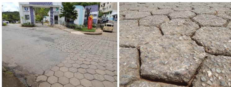
Figura 10 - Trecho 21 (a) transição de revestimento e (b) desgaste dos blocos de concreto
