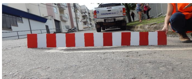
Figura 9 - Afundamento local plástico no trecho 9
