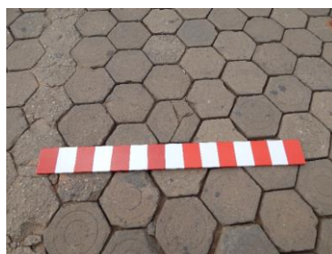
Figura 12 - Blocos sextavados rompidos e ausência de preenchimento das juntas
