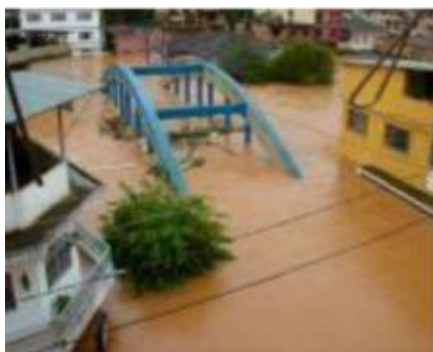
Figura 3 – Água acima da Ponte dos Arcos, em 2003 (Fonte: SANTOS, 2018, p.15).
