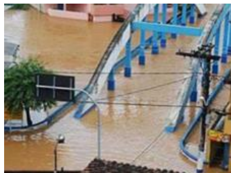
Figura 4 – Água acima da Ponte dos Arcos, em 2009 (Fonte: SANTOS, 2018, p.15).
