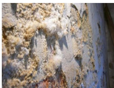
Figura 6 - Parede com crioflorescência. (Fonte: Ligablog, 2016).
