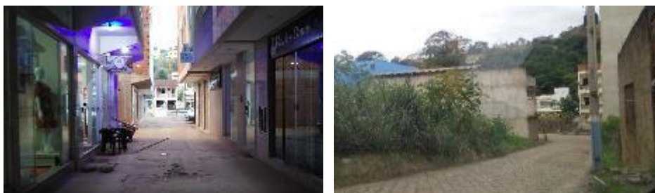
Figuras 28 e 29 – Falta de calçada nas ruas Monsenhor Geraldo da Costa e Inocêncio Braga respectivamente (Fonte: A AUTORA, 2020)
