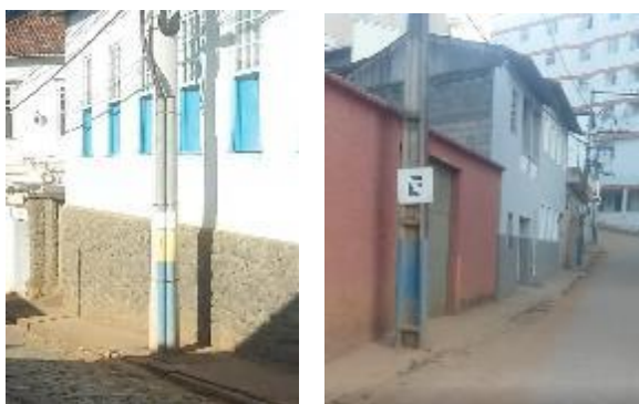
Figuras 22 e 23 – Postes obstruindo a passagem de pedestres nas ruas Olinto de Abreu e Floriano Peixoto respectivamente (Fonte: A AUTORA, 2020)
