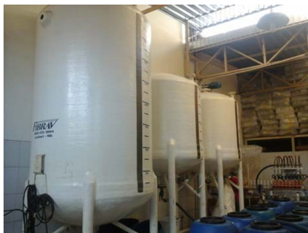
Figura 6 – Tanques de armazenamento do molho de pimenta pré envase
