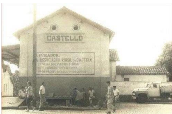
Figura 5 – Estação Castello – década de 1960 – principal marco fundamental da ocupação e desenvolvimento urbano (Fonte: Arquivo Público Municipal, 2020)
