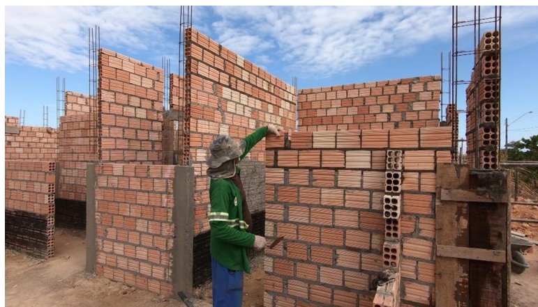
Figura 4 - Edificação em alvenaria sendo executada
