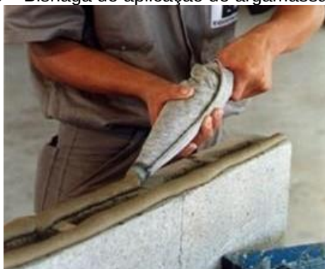
Figura 08 – Bisnaga de aplicação de argamassa estrutural
