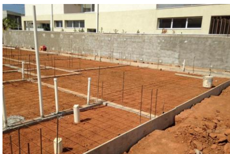
Figura 09 –Preparação para Contra Piso em Alvenaria Estrutural
