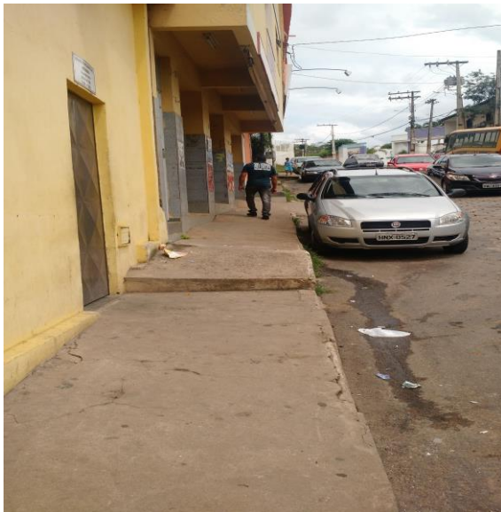
Figura 6 - Calçada deteriorada, com crescimento de vegetação e vazamento, Rua Elói Werner
