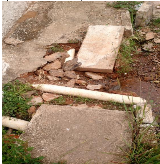
Figura 7 - Calçada quebrada com tubulação aparente e vazamento, Rua Elói Werner.
