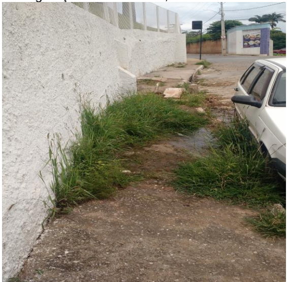
Figura 6 - Calçada deteriorada, com crescimento de vegetação e vazamento, Rua Elói Werner
