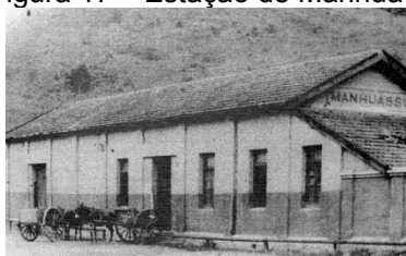
Figura 17 – Estação de Manhuaçu.
