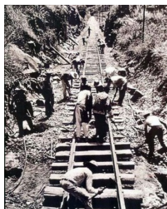
Figura 12 – Homens trabalhando na construção da Estrada de Ferro.
