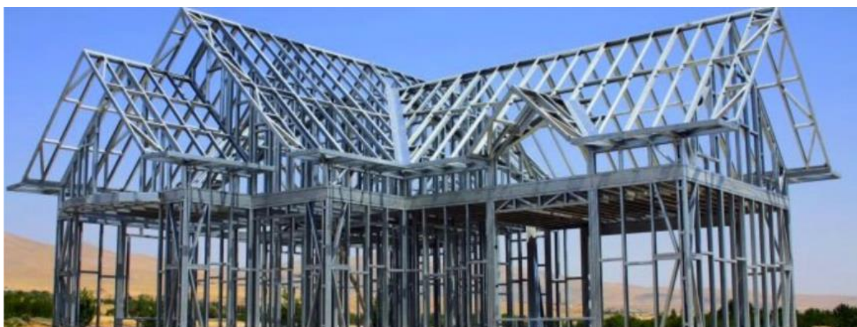
Figura 2 – Estrutura steel frame de uma residência.
