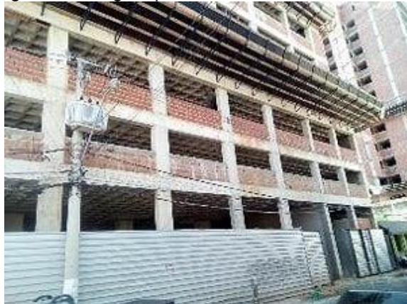
Figura 10 – Vigas que formam o colarinho externo.
