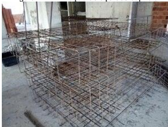
Figura 12 - Armação de aço dos capiteis.
