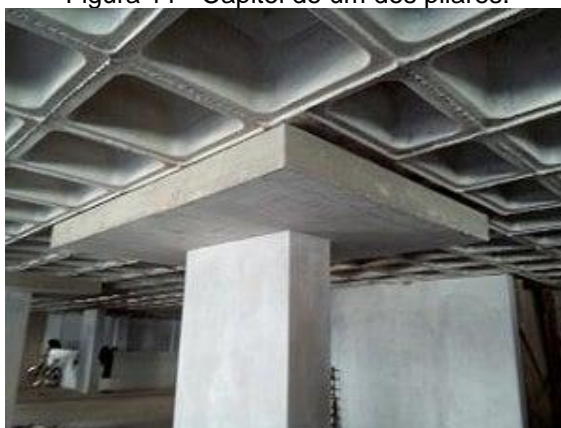
Figura 11 - Capitel de um dos pilares.
