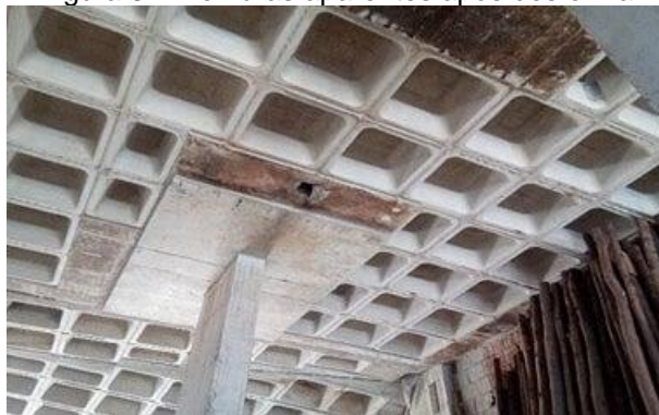
Figura 3 – Nervuras aparentes após desforma
