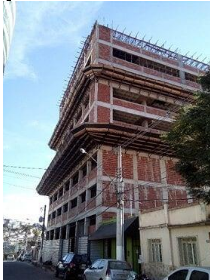
Figura 2 - Edifício comercial analisado.
