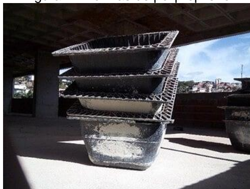
Figura 4 - Fôrmas de polipropileno.
