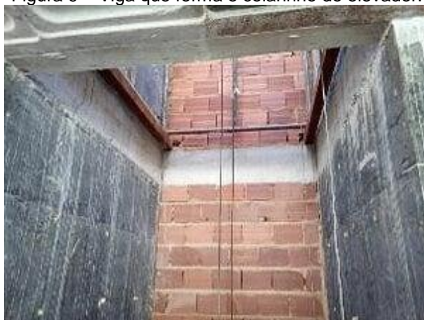
Figura 9 – Viga que forma o colarinho do elevador.
