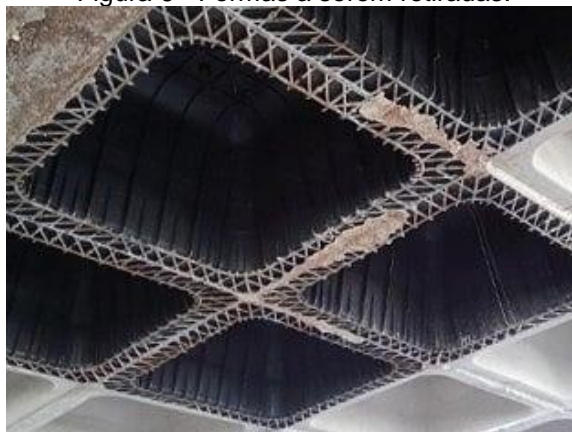
Figura 6 - Formas a serem retiradas.
