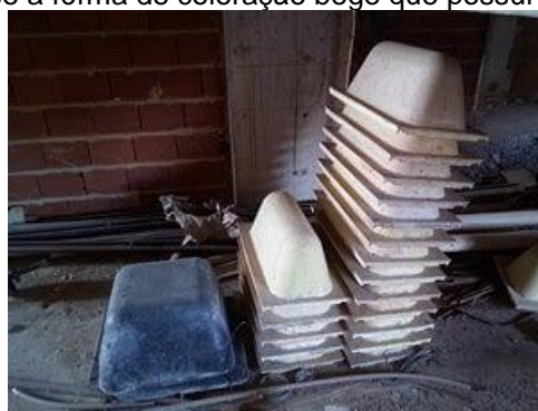
Figura 5 – À esquerda, encontra-se a fôrma de tonalidade preta que possui 60 x 60 cm, à direita, encontra-se a fôrma de coloração bege que possui 35 x 60 cm.
