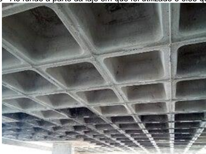
Figura 8 - Ao fundo a parte da laje em que foi utilizado o óleo queimado.
