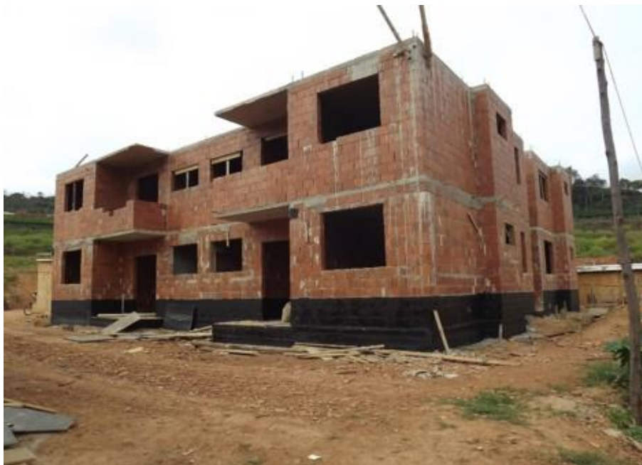
Figura 2 - Fiadas de alvenaria estrutural na obra do condomínio Clube do Sol em Manhauçu/MG.
