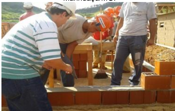
Figura 6 – Aplicação da argamassa em paredes de alvenaria estrutural na obra do clube do sol em Manhauçu/MG.
