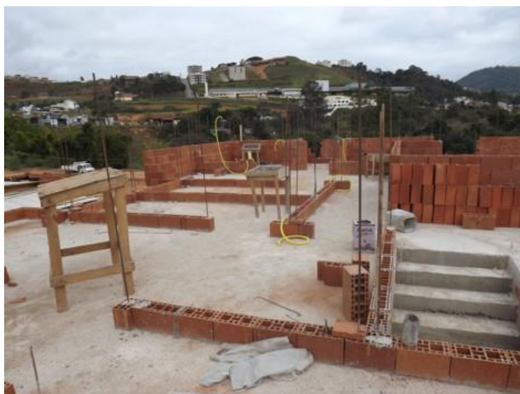
Figura 2 - Fiadas de alvenaria estrutural na obra do condomínio Clube do Sol em Manhauçu/MG.
