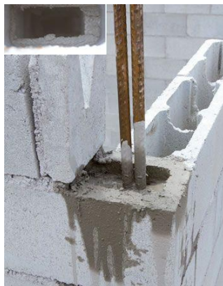
Figura 4 – Armadura para Grautes.
