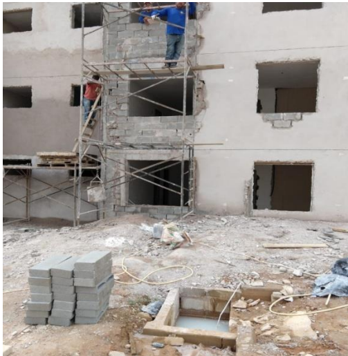
Figura 8 – Parede sendo embolsada sem o chapisco
